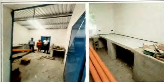
Foto 9: MODULO B vista interior de cocina, acabados en muros y vista de mueble de concreto con azulejo. Puerta de metal ya instalada.
