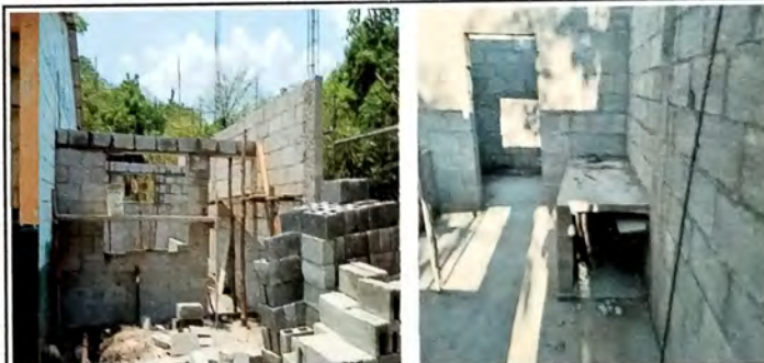
Foto 4: MODULO B Vista frontal y vista interior donde se aprecia el vano para bodega de fondo. Mueble de concreto al lado derecho.
