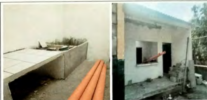
Foto 8: MODULO B Vista interior de cocina mueble de concreto donde se aplico azulejo, Vista Frontal de Modulo de Cocina. Aplicación de acabados repello mas cernido.
