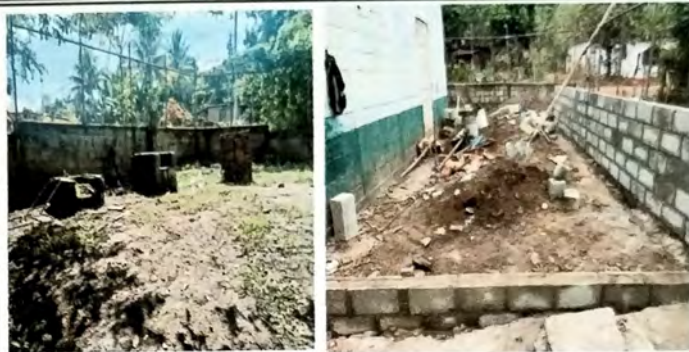
Foto 2: MODULO B COCINA Proceso de levantado posterior a retirar la galera a base de troncos de madera y cubierta de NYLON negro donde cocinaban con una parrilla sostenida por blocks
