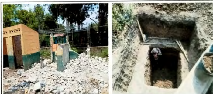
Foto 10: MODULO A servicios sanitarios, se demolio un modulo que estaba con grietas por undimiento en suelo y estaba ya desplomado. Excavacion de para fosa septica.
