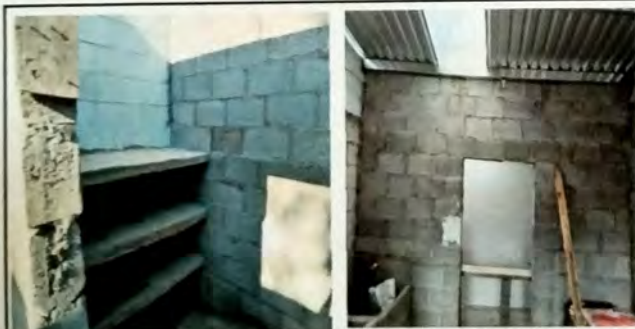
Foto 5: MODULO B vista interna de cocina con bases de concreto en muro lateral izquierdo para guardar utensilios de cocina.
