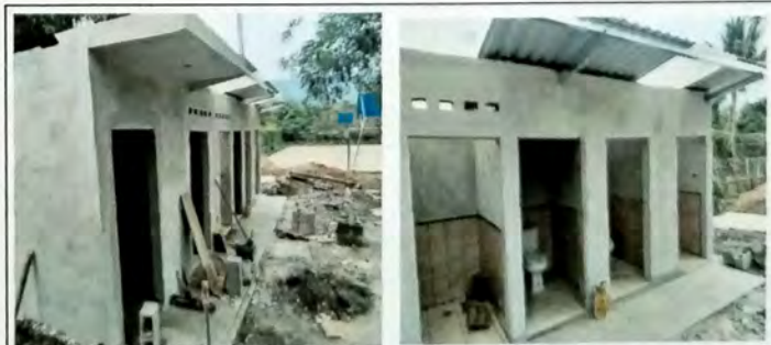
Foto 12: MODULO A servicios sanitarios, vista muros con aplicación de repello y cernido, mas instalacion de azulejo en muros. Instalacion de lamina troquelada cal 26 y en un cubiculo para sanitario se fundo losa para sustentar el deposito para almacenamiento de agua.
