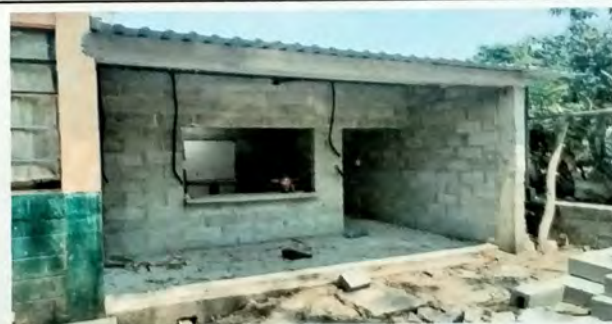
Foto 6: MODULO B Vista frontal de Cocina.
