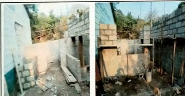
Foto 3: MODULO B proceso de levantado de muros
